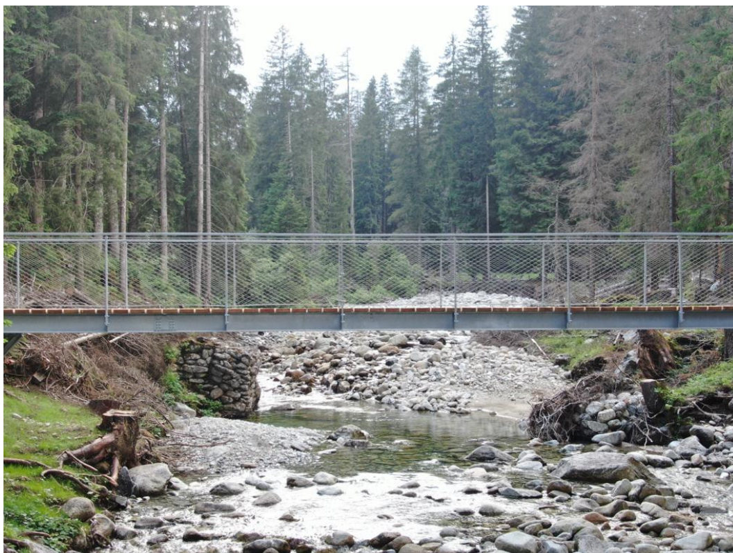
Foto 1 e 2 : passerella su torrente in val del Leno, Valdaone (TN) Progetto Endes Engineering - giugno 2023
