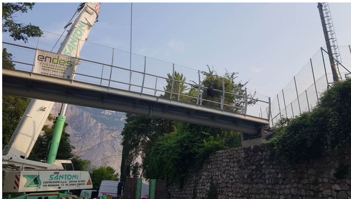
Foto 3 e 4 : passerella per accesso al castello di Drena (TN) Progetto Endes Engineering - giugno 2023
