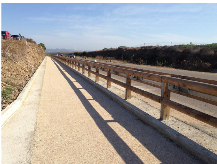
Foto 10 – 11. Esempi di parapetti di separazione tra varie tipologie di viabilità – fonte Metalwood Trento.
