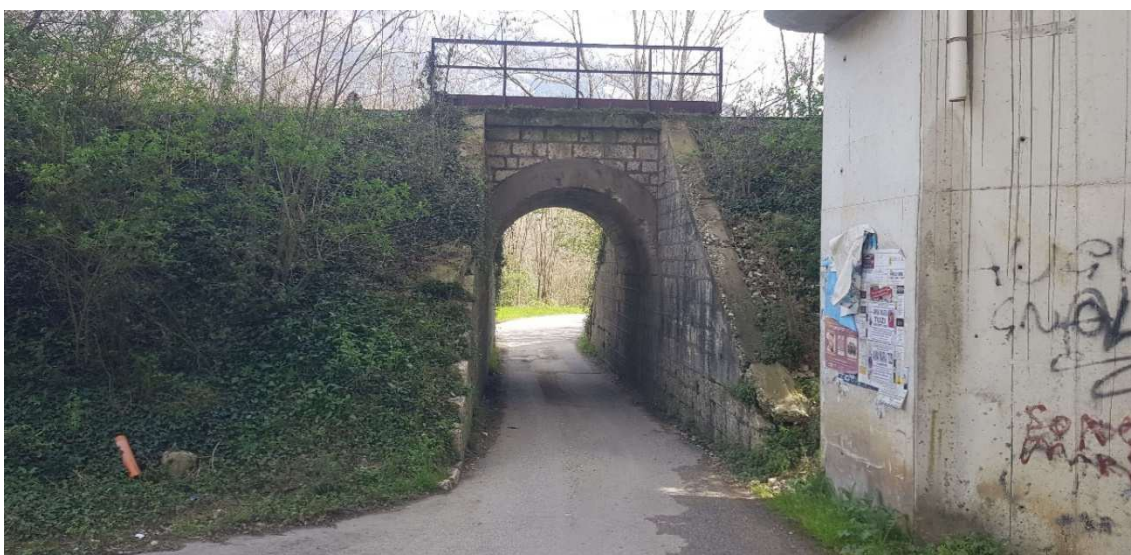
D01 – sottopasso ferroviario
