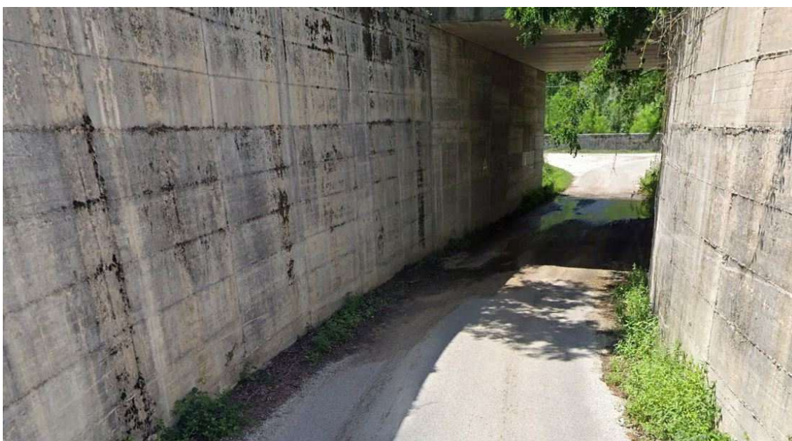
B14 - Il sottopasso della superstrada costituisce il punto di inizio del tratto che conduce a Balsorano Nuova e al sito della Madonna delle Grazie
